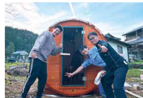
サウナキット枠組み完成(12月)
