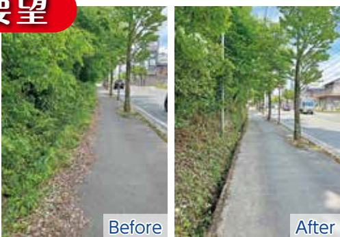
歩道に樹木がせりだし歩行者支障あり
