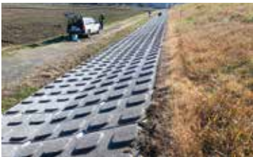
堤防の裏法補強工事(日野川)
