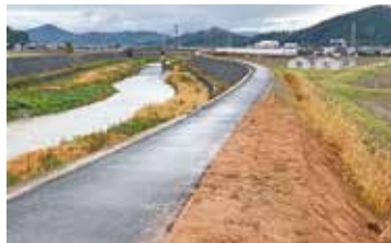
堤防天端の強化工事(江端川)
