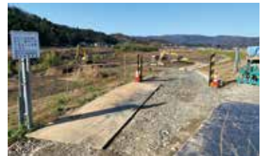
河道掘削工事(日野川)
